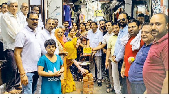
गन्नीौर। दीगरा मार्केट में गली निर्माण कार्य का शुभारंभ करती बुजुर्ग महिलाएं।
